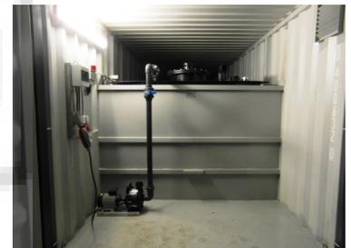
**Für die Außenlagerung wird der TIW in einen extra vorbereiteten 10/20/30/40 Fuß-Seecontainer eingebaut.** das Schaft u.a. Sicherheit gegen Vandalismus und gegen Witterungseinflüsse. Der Container wird nach Kunden Farbwunsch lackiert . Dieser hat im Dombereich des TIW eine Luke von ca. 1.000 x 1.000 mm Größe im Dach, die freien Zugang zum Dom und gegebenenfalls zu elektrischen Anschlüssen
