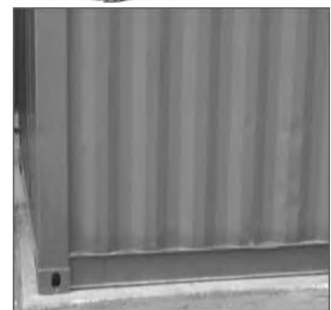
Platten Fundament Aufstellung
